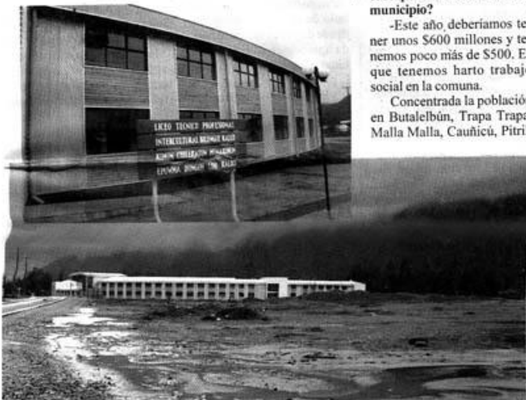
Entre la plaza y el liceo, que se ve al fondo, se construirá la futura Municipalidad de Ralco.
